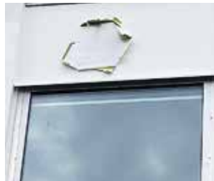
BEHÖVER RUSTAS. Fasaden på Väsby skola.
